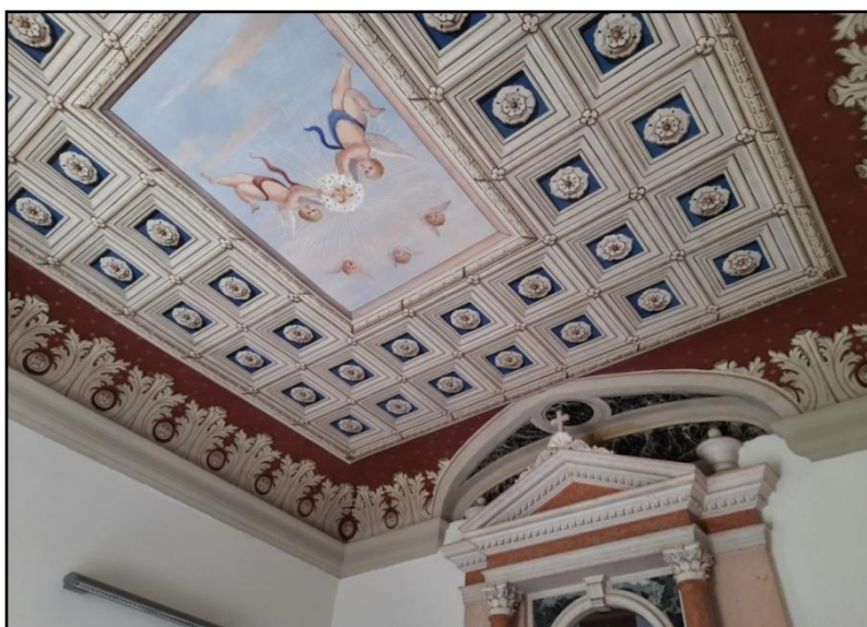
Il soffitto a cassettoni dell'oratorio
