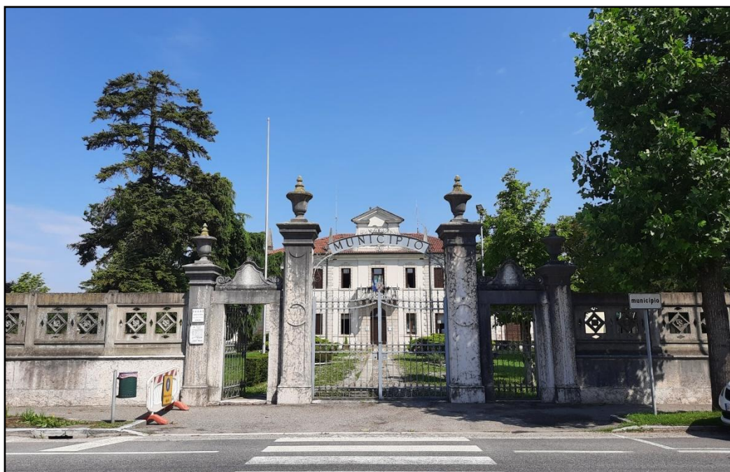
La recinzione con il cancello d'ingresso in asse con la villa.
